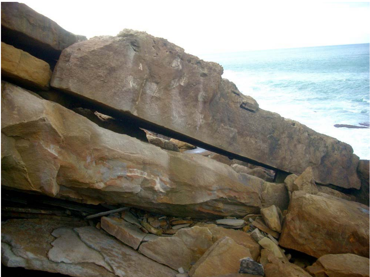
Figura 16. Escarpes laterales en el sector Este de Larretxiki, donde se aprecia la estratificación delgada y alternante de la serie flysch (arriba) y bloques tabulares de arenisca que han colapsado dejando espacios entre ellos (debajo). Bajo los más grandes llegan a formarse cuevas de recubrimiento de hasta varias decenas de metros de desarrollo.
