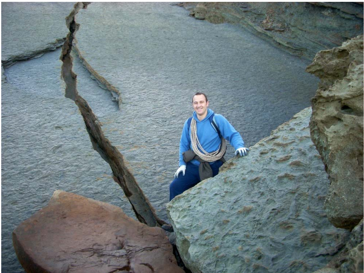
Figura 2. Flysch de Larretxiki, Igueldo W. Los paquetes de estratificación delgada (de lutitas, margas y arenisca) resultan más erosionables, se fracturan con facilidad y son muy deslizantes, produciendo la rotura y colapso de los paquetes de estratos gruesos de arenisca sobre ellos.
