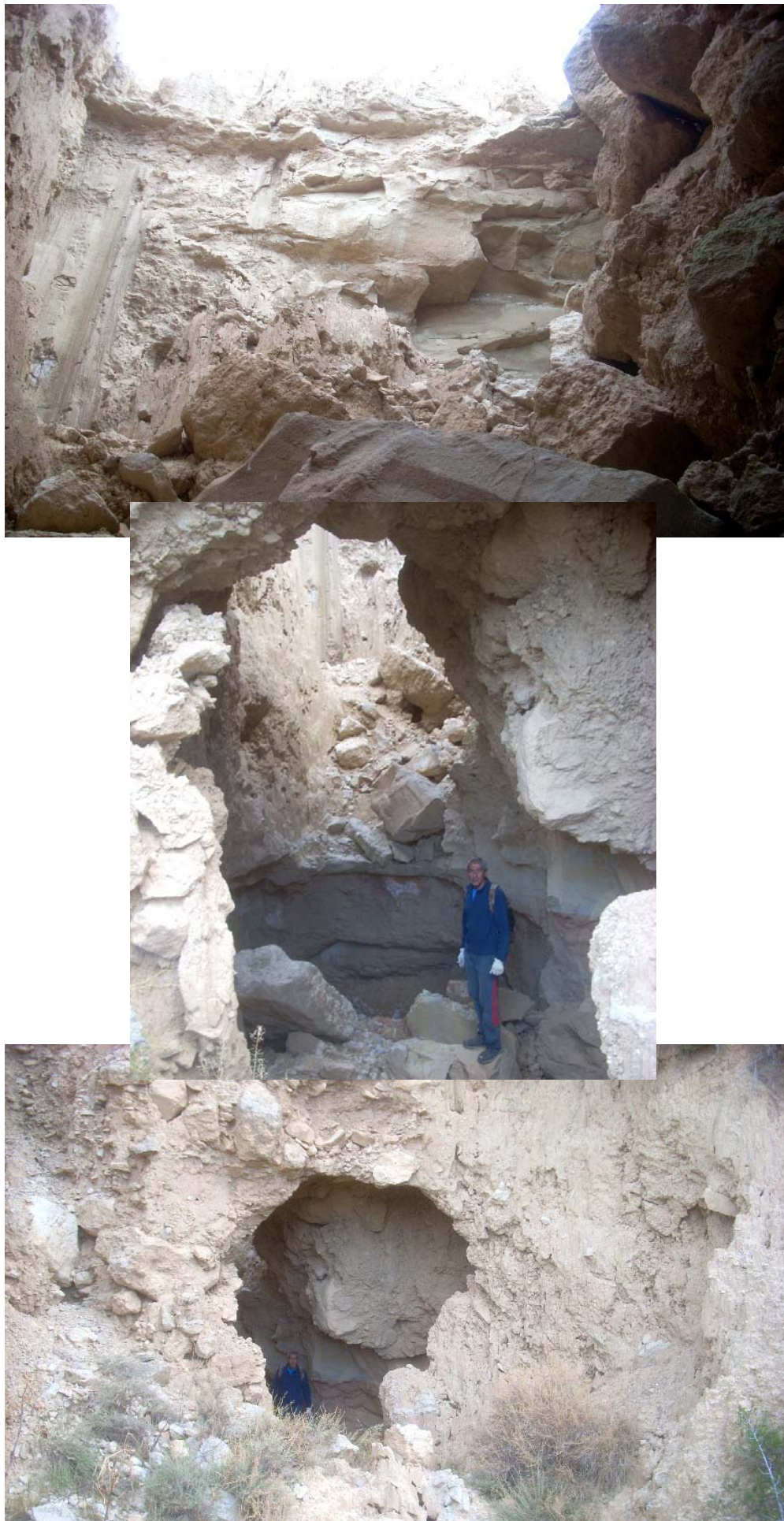
Figura 40. Sistema de drenaje subterráneo 1. Bajo el cañón-sima superior, que se inicia por encima del collado entre las Nasas, hay una cueva-túnel con una amplia claraboya cerrada por una pared. Su interior está colapsado, pero se sitúa sobre la traza de la galería inferior que recorre el cañón.
