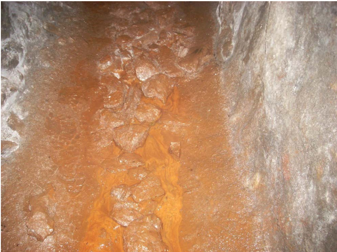
Figura 03. Galería principal de la mina Txangoa Oeste, de 220 m de desarrollo, con un hilo de agua en su cauce.
