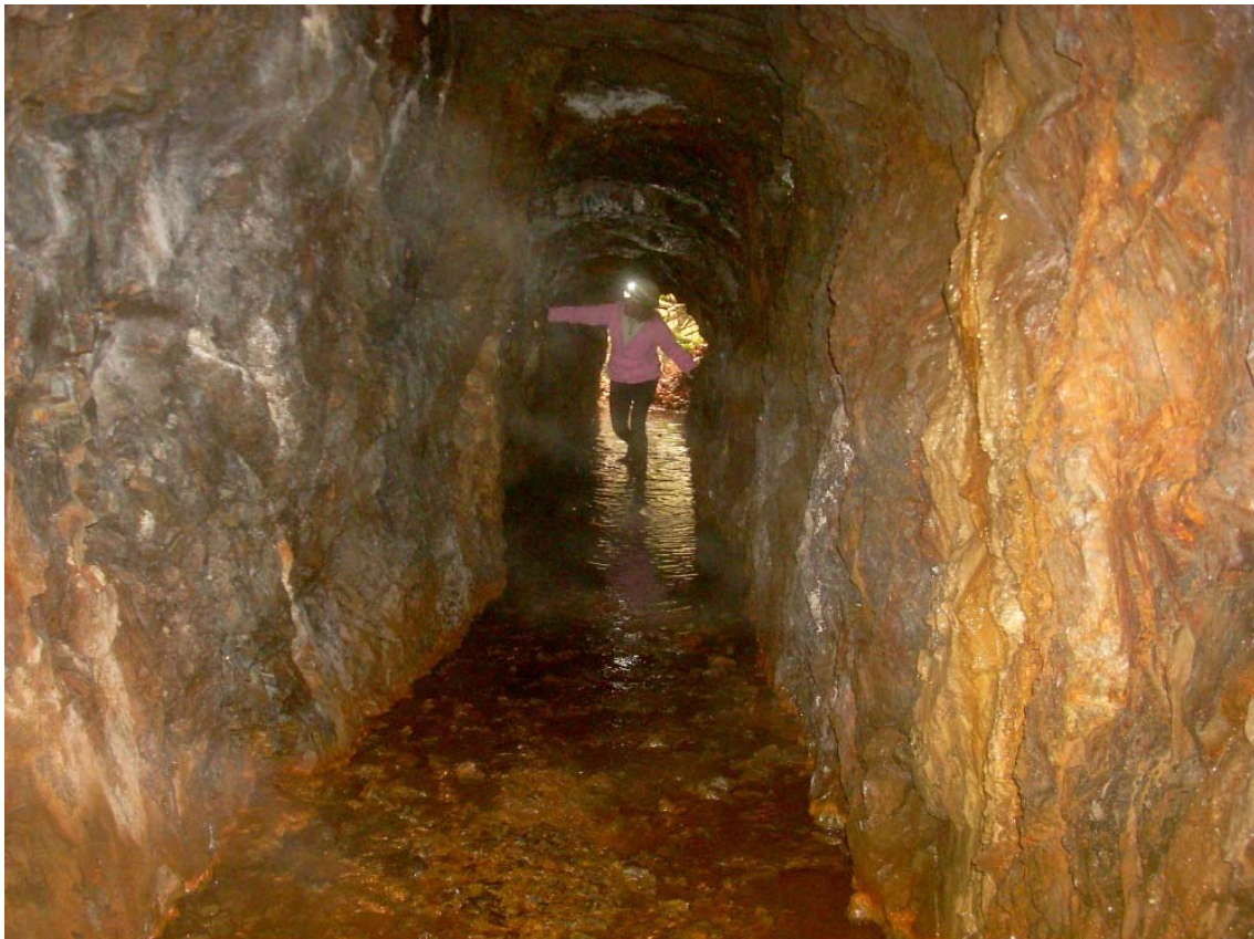
Figura 08. Tramo inundado de entrada de la Mina de los Alemanes, donde se aprecian las pizarras de la roca-caja y pequeños recubrimientos de espeleotemas diversas (de calcita, pirita, calcopirita y pirrotina).
