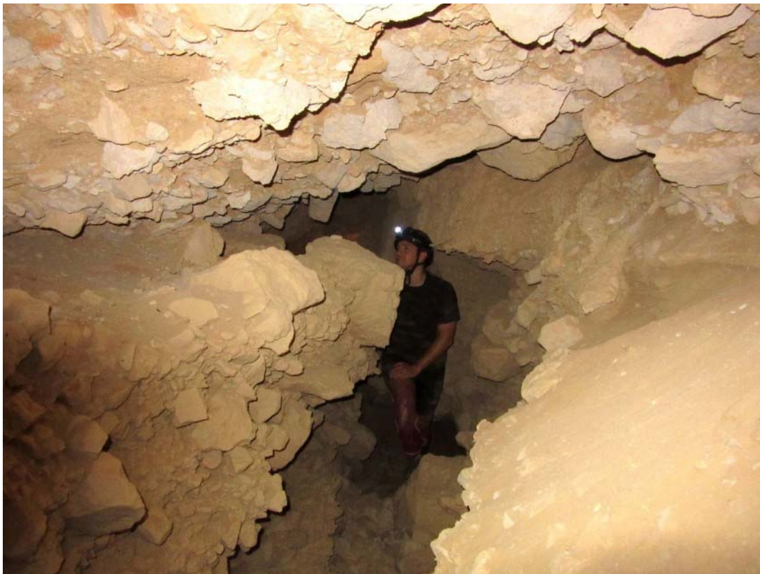
Figura 09. Son frecuentes galerías que atraviesan niveles de arcilla con clastos, incluyendo coluviones de ladera. Los fragmentos más compactos pueden estar bien adheridos o, por el contrario, ser propensos a colapsos ante el menor roce, por lo que hay que evitar apoyarse en ellos o tocarlos. Sima Nasa Baja 02, de 158 m de desarrollo y -18 m de desnivel.
