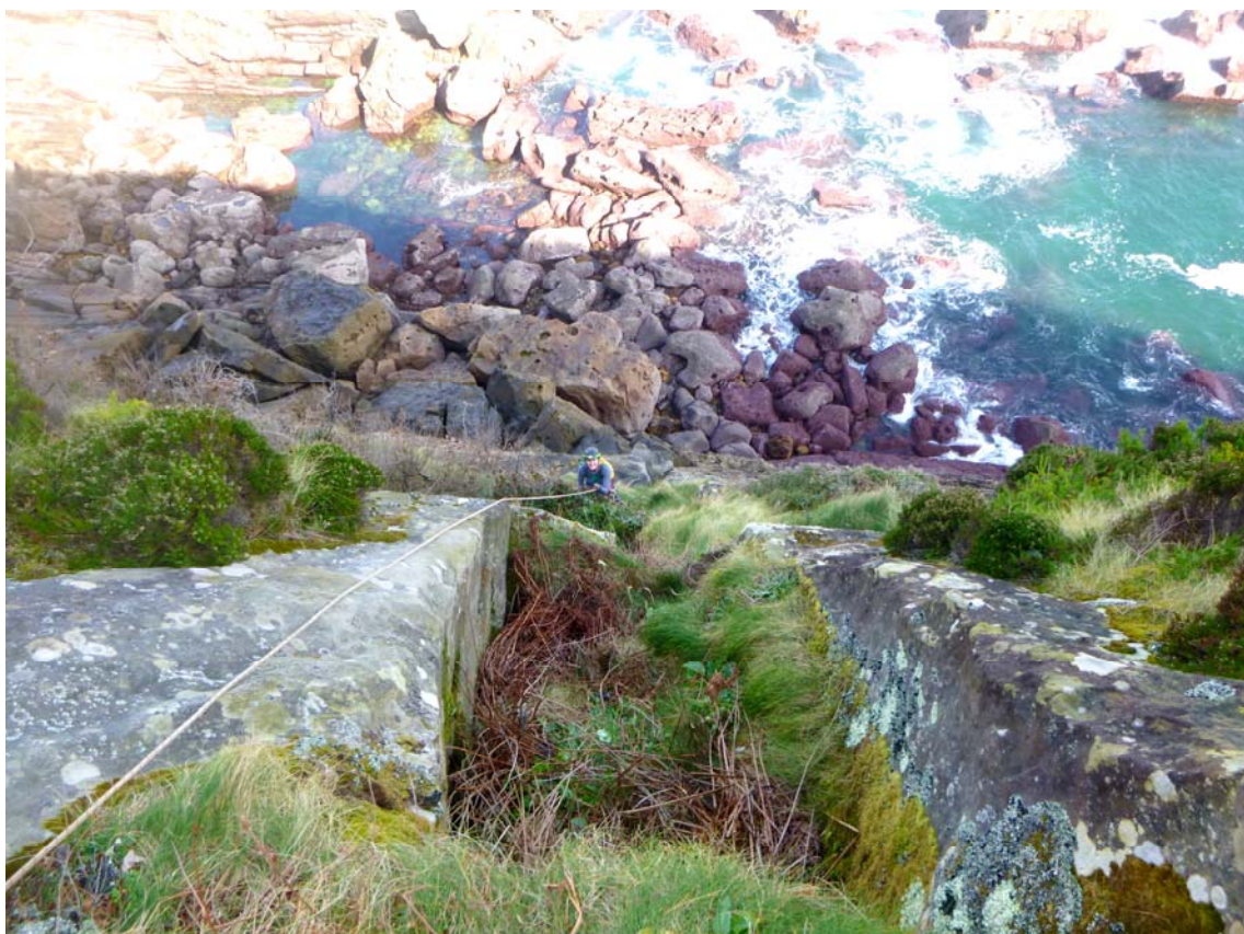
Figura 22. Secuencia del ascenso en jumars del tramo inferior. Visto desde la cornisa de la cota -22 m.
