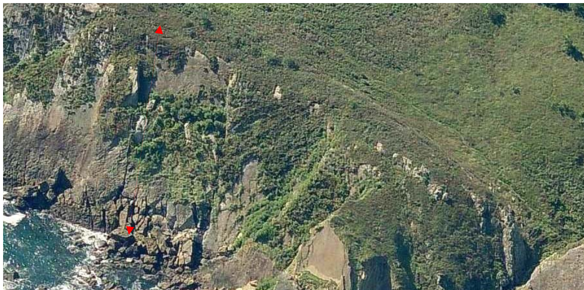
Figura 02. Localización de los acantilados de Barraka (arriba, flecha negra), del sector explorado (centro) y ampliación del mismo (debajo). Fuente: cartografía digital SIG de Gipuzkoa: b5m). La flecha roja indica la ruta de descenso. Se aprecia la cornisa de la cota -22 m y el tramo que ha deslizado entre las fracturas E y W.
