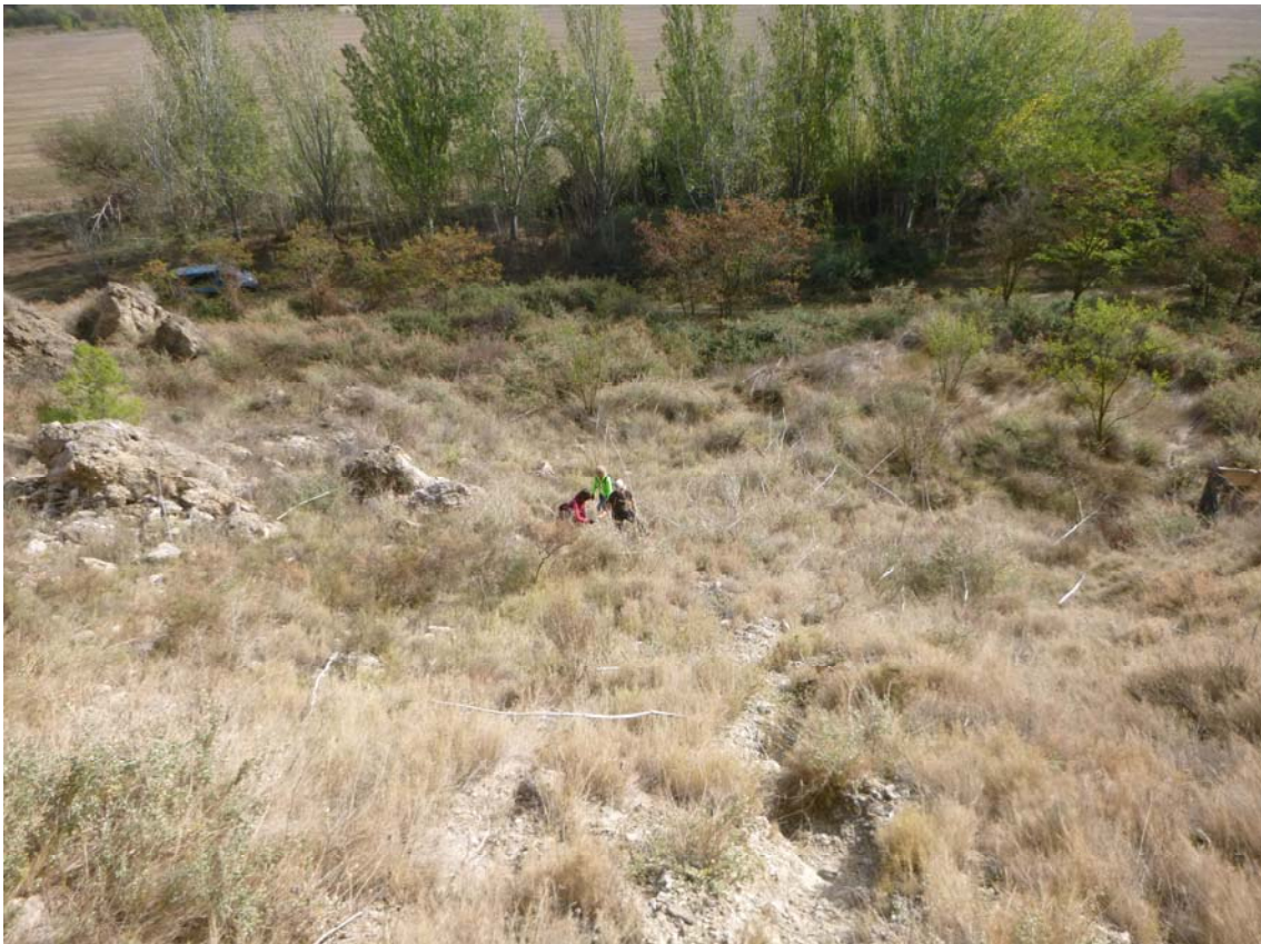
Figura 03. Escarpes verticales y taludes basales en el sector B de los Acantilados de Falces. Puede apreciarse una pequeña boca circular colgada en la pared y cárcavas en el talud.
