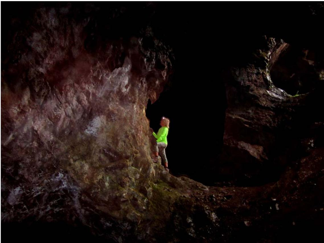
**Figura 03.** La galería principal de la mina presenta claraboyas de +40 m y pilares de roca a lo largo de su trayecto.
