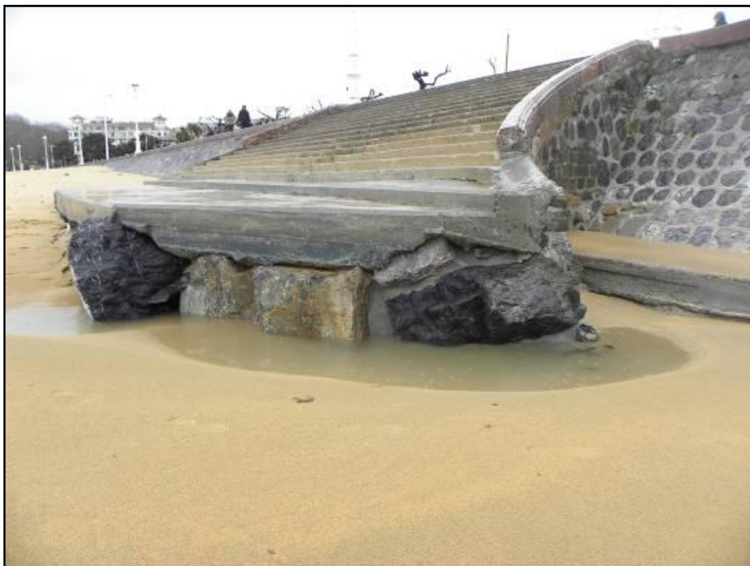
Figura 40. Cimentación de las escaleras occidentales al descubierto.
