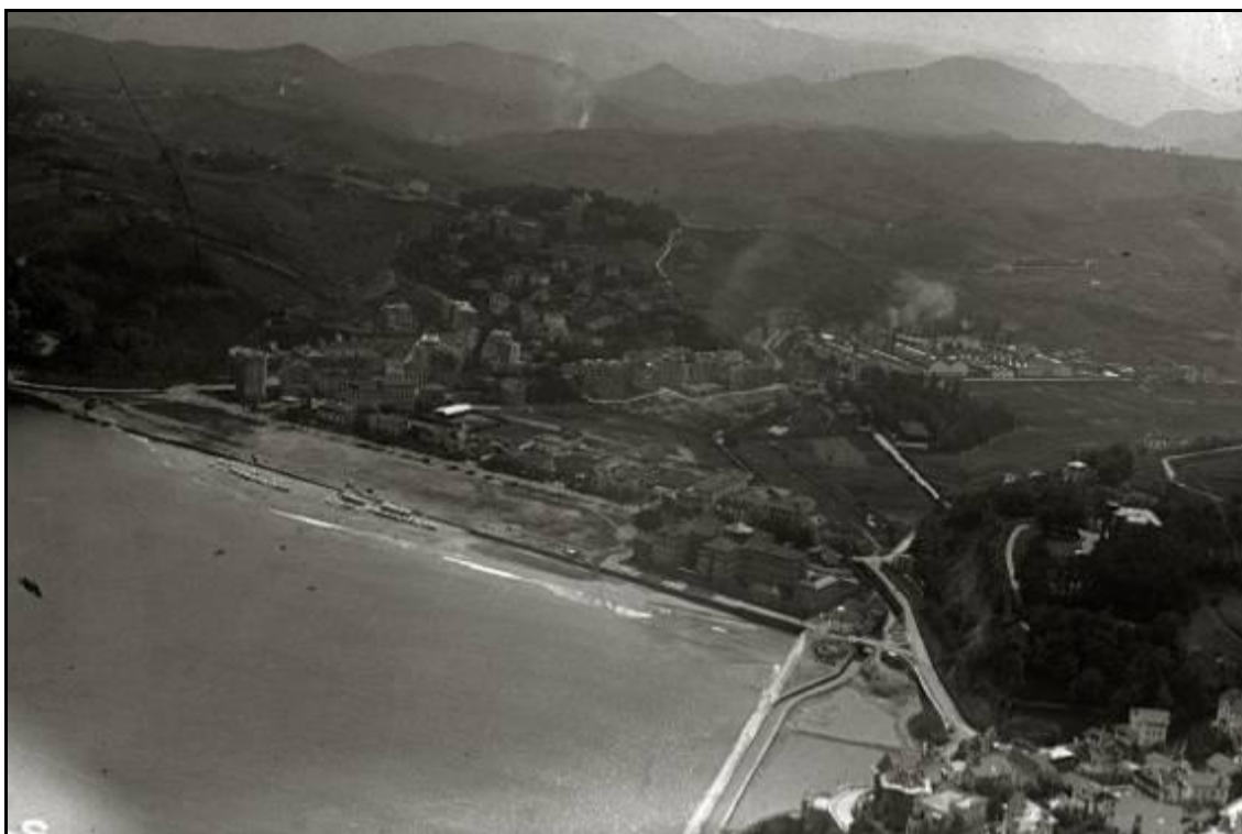
Figura 3. Panorámica de Ondarreta con el campo de maniobras, la cárcel y el colector en construcción.
