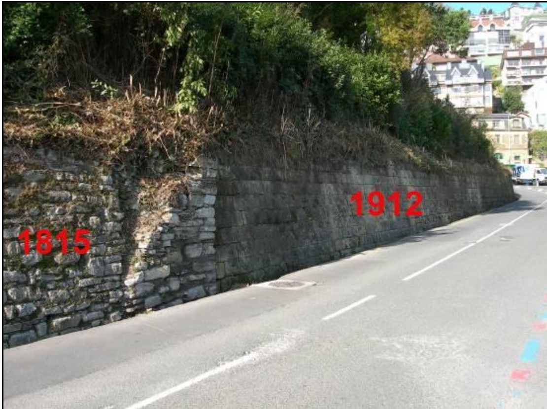
Figura 17. Muro de mampostería caliza (1815) y muro de bloques “sillares” de piedra de arenisca (1912).
