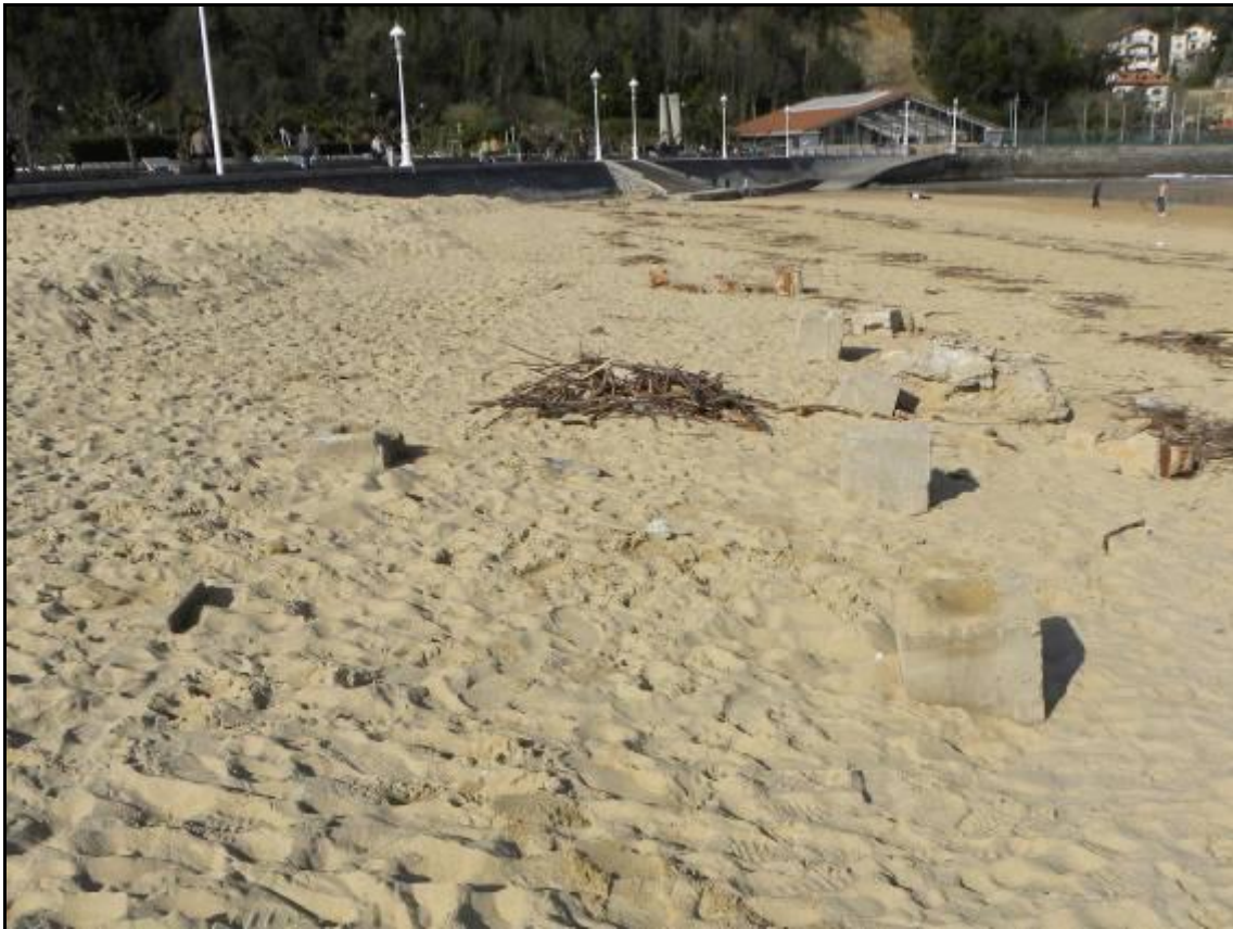
Figura 29. Cimentación alineada de las columnas del graderío norte del Campo Hípico de Ondarreta.
