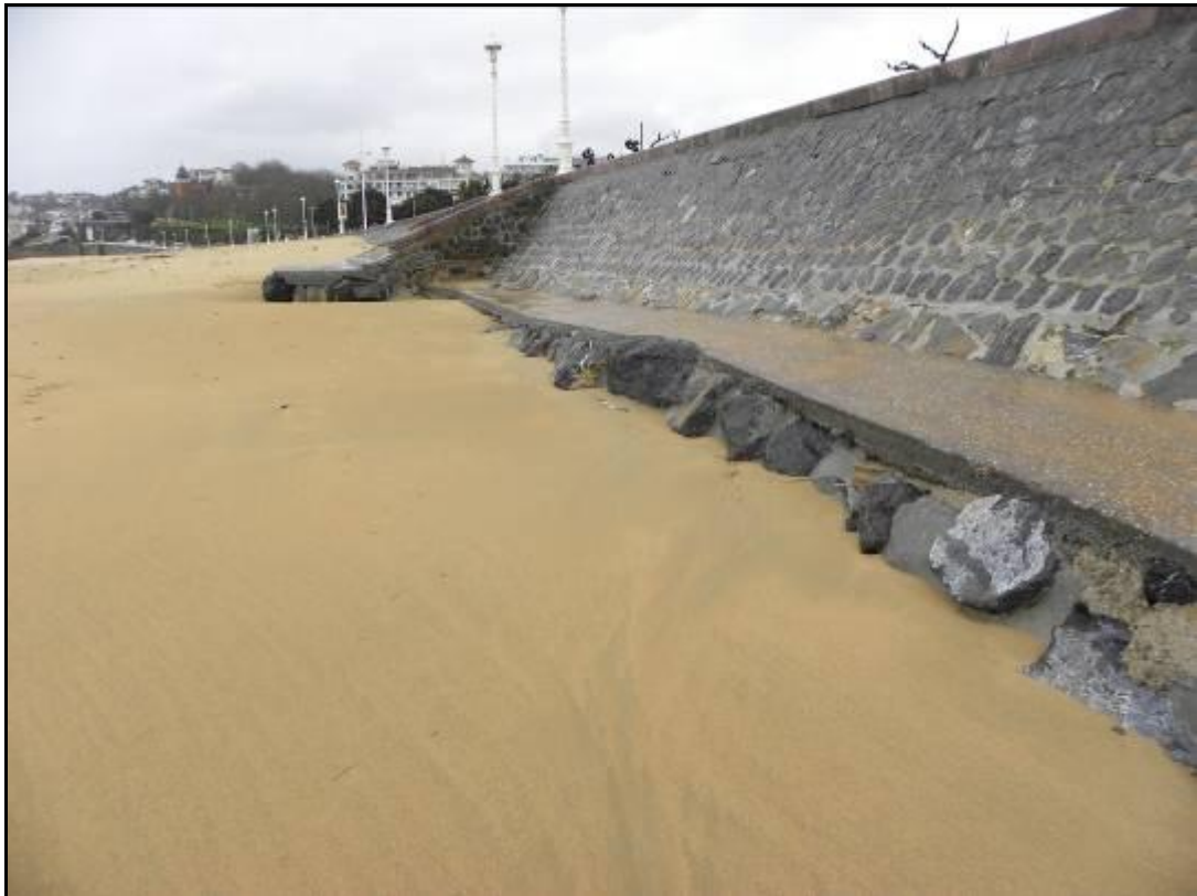
Figura 39. Cimentación del paseo de los jardines de Ondarreta al descubierto.
