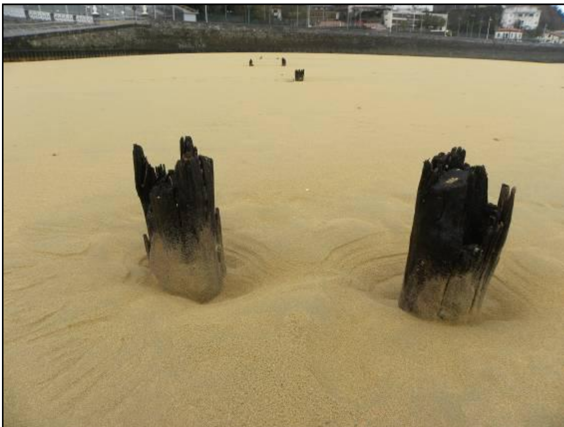
Figura 34. Cubeta anular por retirada de arena alrededor de los postes.
