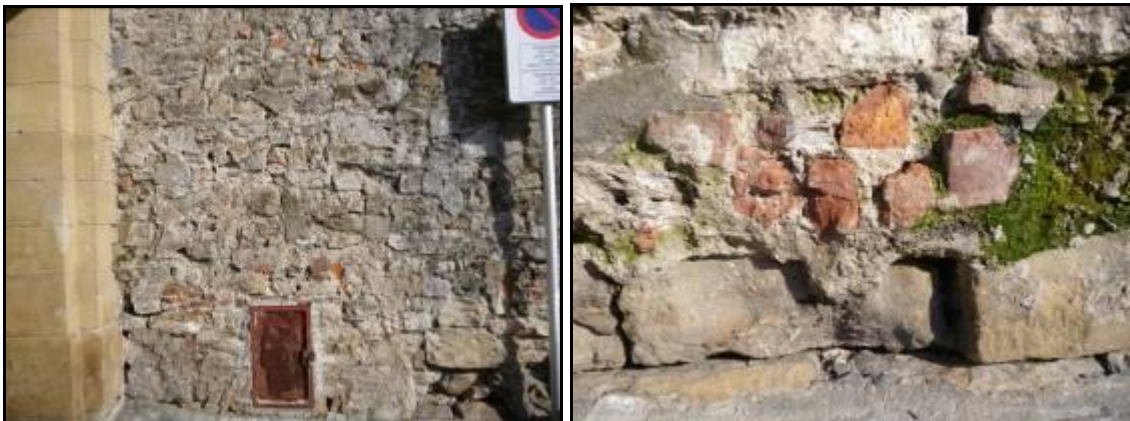
Figura 13. Reparaciones cerca de Portaletas en la muralla del Muelle.
