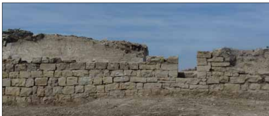
Vista del muro de cierre este y el acceso UE 1141 (S. C. Aranzadi).
