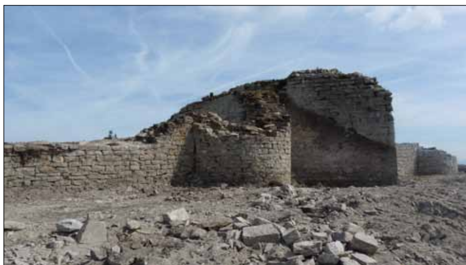
Vista del ábside de la capilla sur y del vértice de la torre principal (S. C. Aranzadi).
